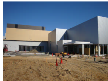
南側玄関付近
