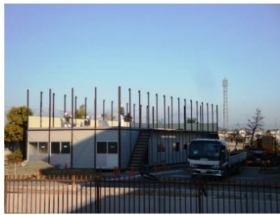
屋外付帯工事が始まったことから現場事務所を移転し元の事務所は解体を始めた
