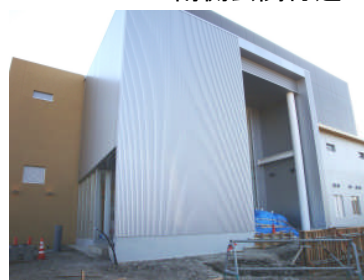
北側玄関付近
