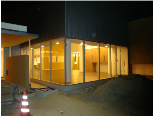
南側玄関付近の外観
