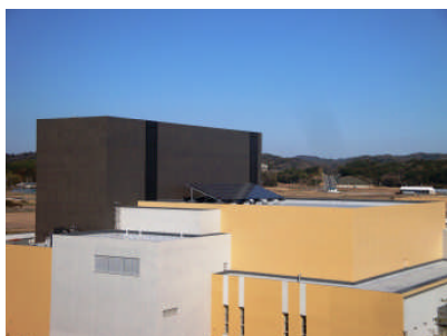
ホール棟の屋上に太陽光発電システム用のパネルを設置
