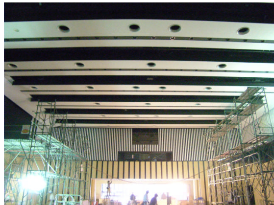
多機能ホール内部の工事の様子
