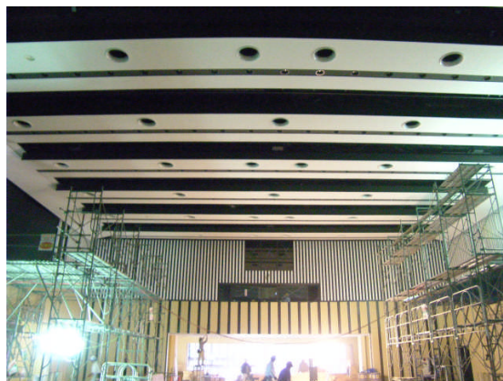
多機能ホール内部の工事の様子
