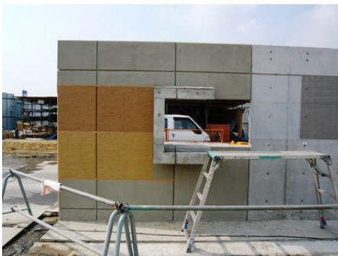
実際の壁と同様のコンクリートに塗装した色見本です。太陽の光り方によって色合いが違って見えるため、確認作業は屋外で行います。
