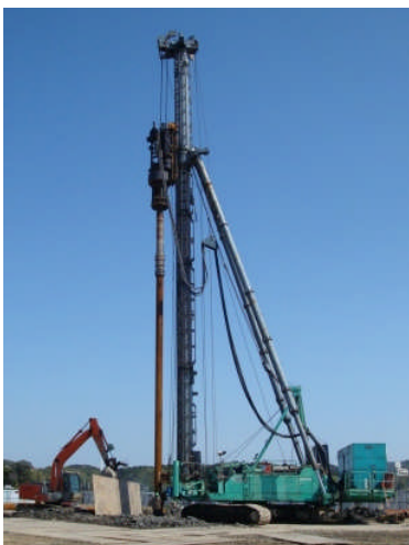
杭工事用重機
