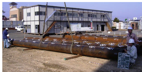
長さの異なる杭を溶接して使用
