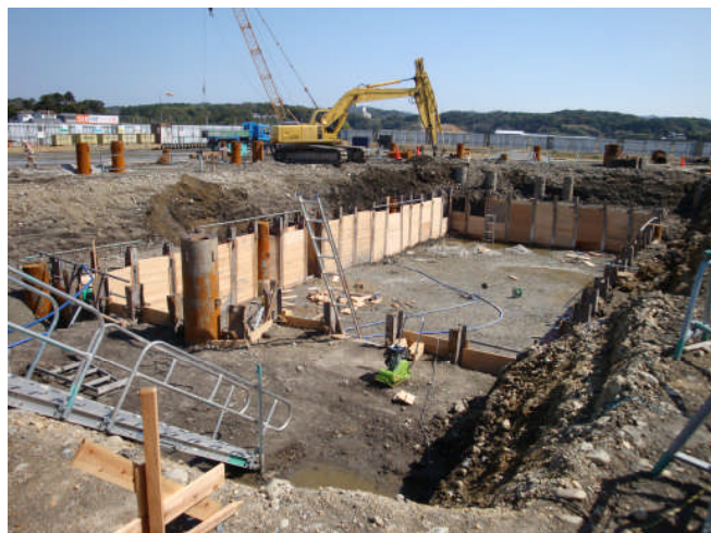
地下ピット部分の工事
