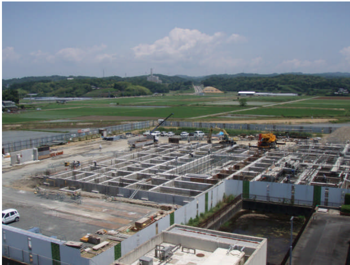
平成21年6月8日現在の建設現場の様相(浅羽支所屋上から撮影)
